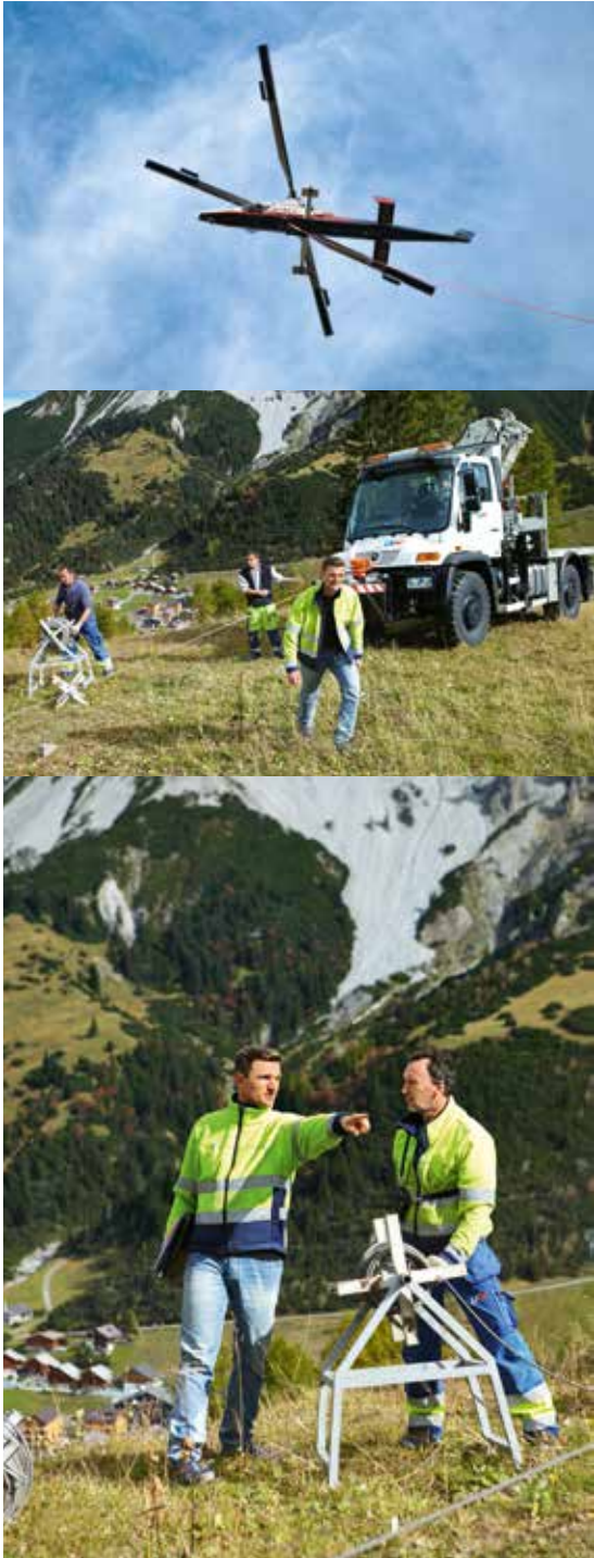
Als Netzelektriker geht es auch schon mal hoch hinaus. Gefragt sind aber auch «geerdete» Persönlichkeiten.
